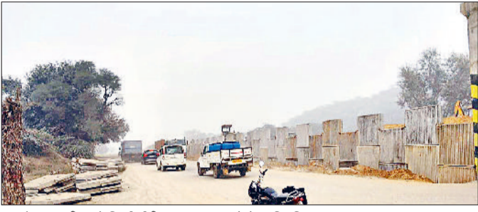
नारनौल। ताजीपुर में निर्माणाधीन अंडरपास। फोटो: हरिभूमि
